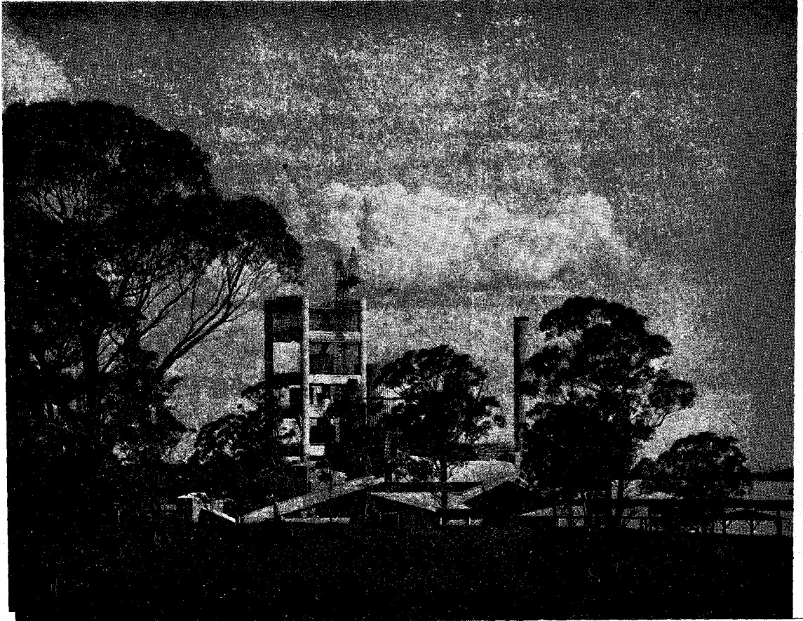
田園的인 環境을 보여주고 있는 工場모습, 사진에 나와있는 stack는 현재의 1450tpd 濕式 工程 키른의 것이다. 前而의 建物과 콘베이어는 新設되는 施設로서 原料 均質化 시스템의 一部分이다.
