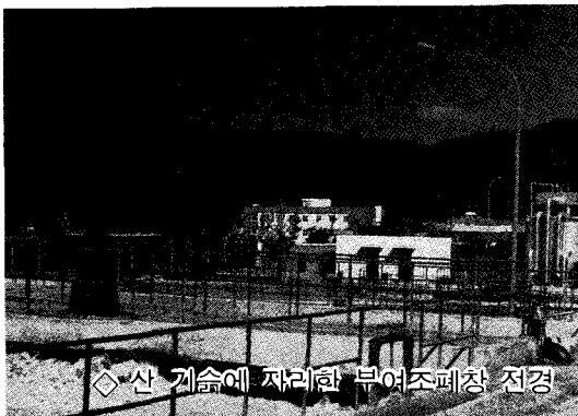
본 창은 대기, 수질 공히 1종 업체로서 폐수량이 일일  $3000\text{m}^3$ ~ $3500\text{m}^3$  정도로 증해폐수(일 500m<sup>3</sup> 정도)와 초지일반폐수(일 3000m<sup>3</sup> 정도)로 구분되며, 혼합폐수의 성상은 PH 7.1~7.6, BOD 160, COD 170, SS 190mg/l 정도로 모든 항목이 그리 높지 않은 편이다. 폐수처리의 개요를 살펴보면, 폐수는 Screen을 거쳐 조정조로 유입되고 필요에 따라 산 또는 알카리에 의한 중화전처리를 거쳐 1차 침전조에서 고액분리되어 상등수만 폭기조로 유입되며, 일반적으로는 혼합
