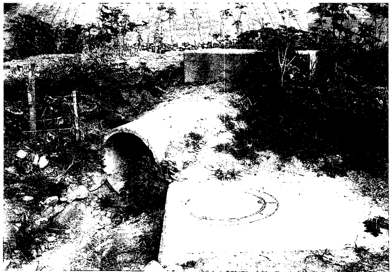
사진1 청천시 발생오수가 전량 차집되는 차집시설
