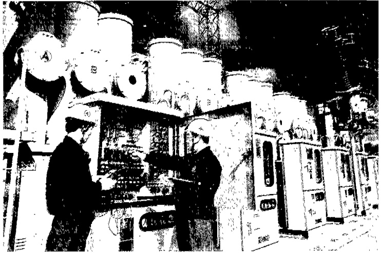
▲ 최근 대형안전사고에 따른 예방점검이 요구되는 시점에 특고압 변압기 패널 안전점검을 실시하는 점검반원들
