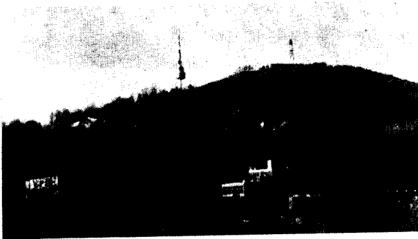
그림 5 남산외인아파트 발파해체 후
