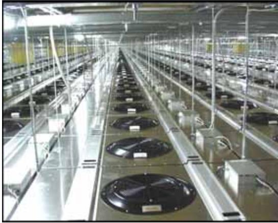
그림 3. FFU 설치 모습 (면적의 100%)
