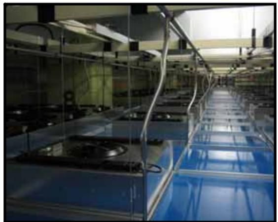
그림 2. FFU 설치 모습 (면적의 25%)
