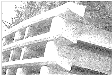
그림 4. 옹벽 전면부 시공직후 사진
