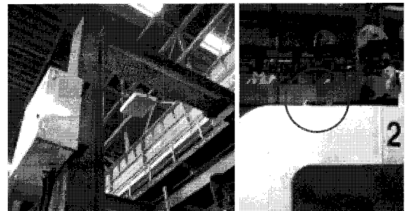
그림 8. 실제 설치 모습. Fig. 8. The real picture of the system.
