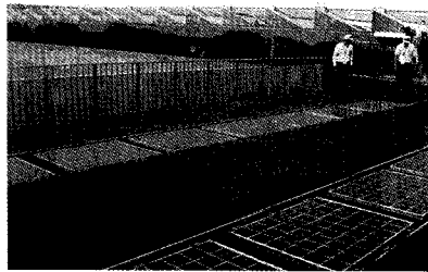
그림 4 도요타 썬썬미 공장내에 설치된 솔라 패널
