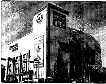
2008년에 오픈한 부천 여월 그린스토어는 국내 최초로 판매시설부문 친환경건축물 최우수 인증을 획득했다
