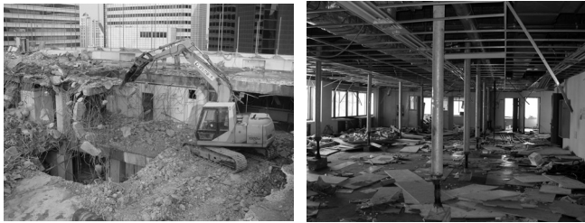
(a) 슬래브 해체 전경 (b) 작업 층 하부 잭 서포트 보강
