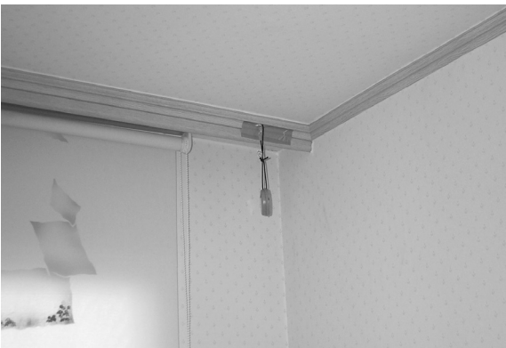
그림 3. 온습도 자동기록 장치를 이용한 실내 온습도 측정
