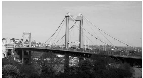
그림 1 Tamar Bridge, UK
