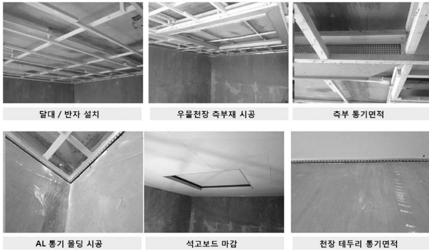
그림 5 통기성 천장 시스템 목업시공
