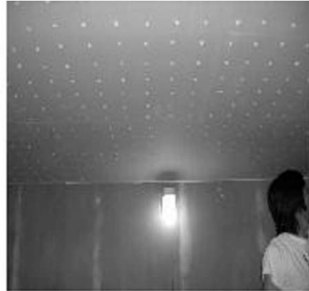
그림 2 하부층 세대의 천장에 석고보드를 시공한 후 표면에 타공을 하는 장면
