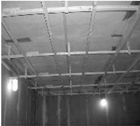
그림 2 하부층 세대의 천장에 석고보드를 시공한 후 표면에 타공을 하는 장면
