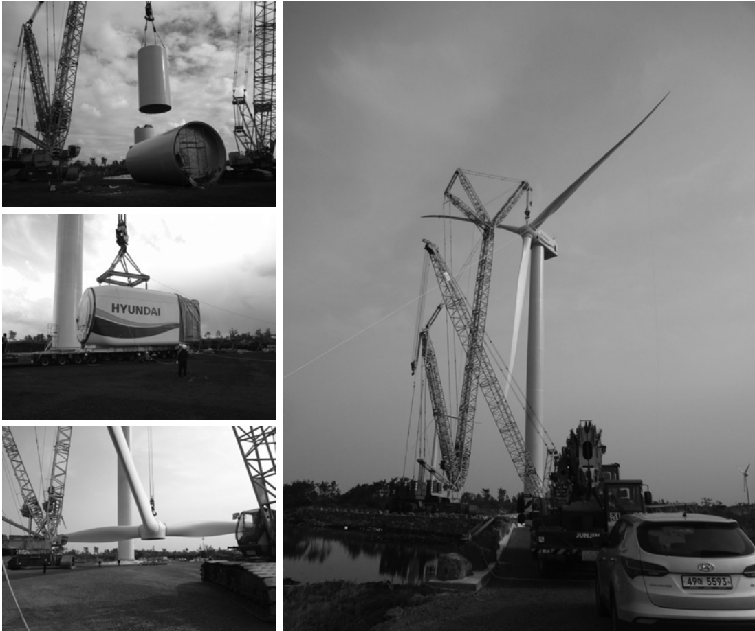
[그림 3] 해상터빈 설치
