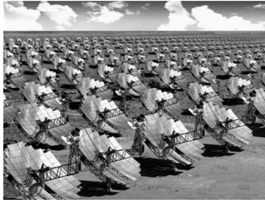
그림 6 태양열 이용 3 kW 스텔링 컨버터, infinia(왼쪽), 발전 단지, Boeing, Kockums(오른쪽)
