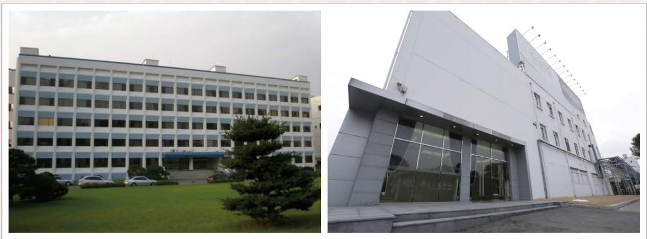
그림 1 효성중공업 안양연구소 및 차세대 전력기술 실험센터 전경
